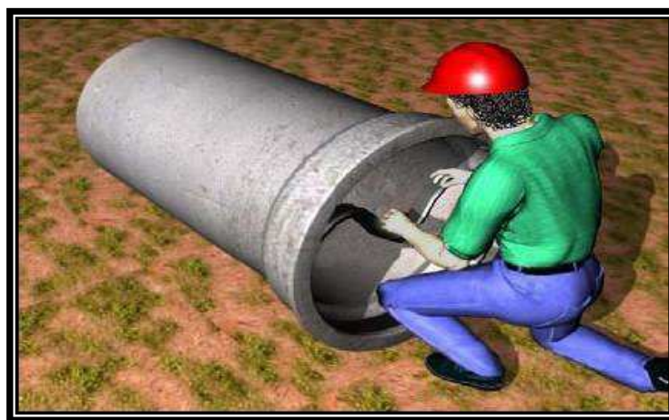
Figura 13 - Colocação do anel de borracha
