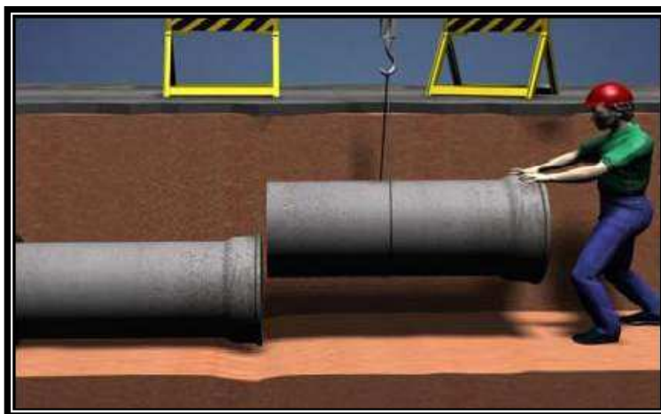
Figura 15 – Acoplamento de tubos de concreto
