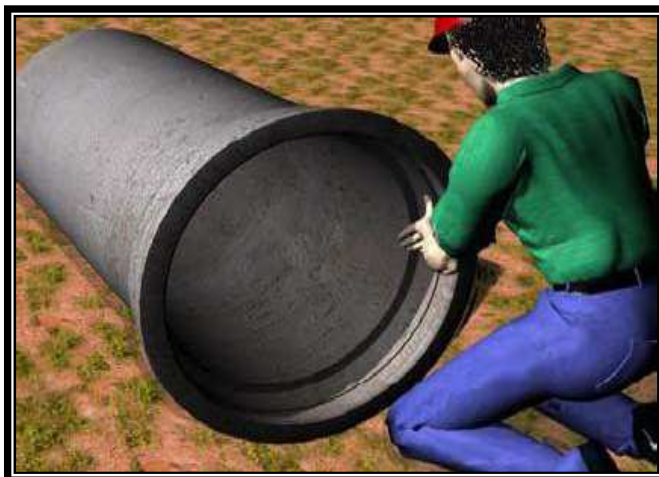
Figura 14 - Lubrificação do anel de borracha
